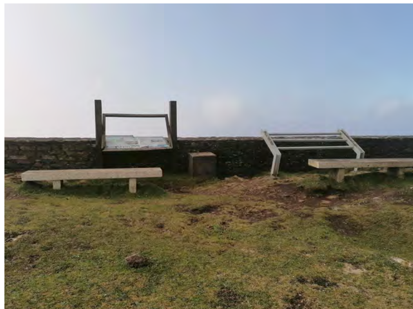
Figura 69. Paneis informativos en mal estado de conservación
