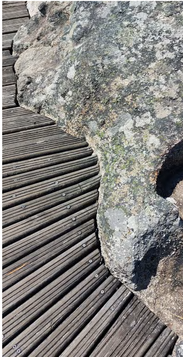
Figura 103. Encontro de pavimento de madeira con pedra senlleira no miradoiro da Siradella, O Grove GAP VIII
