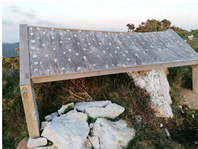
Figura 65. Panel informativo en mal estado de conservación
