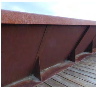
Figura 115. Detalles de defensas de aceiro
