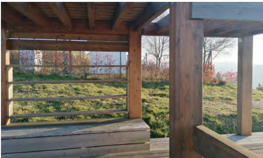
Figura 127. A propia estrutura do miradoiro tipo refuxio, sumado á plantación dunha sebe vexetal, pretenden mitigar a presenza dunha instalación de telecomunicacións
