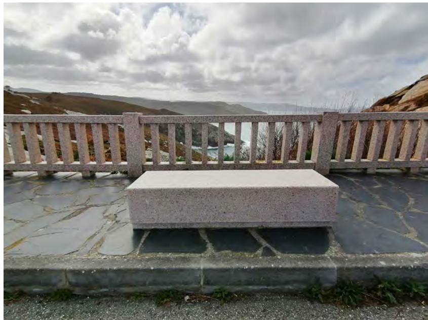
Figura 66. Varanda pouco permeable á vista en fronte dun banco
