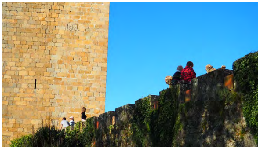
Figura 94. Miradoiro do Castelo de Monforte de Lemos GAP III
