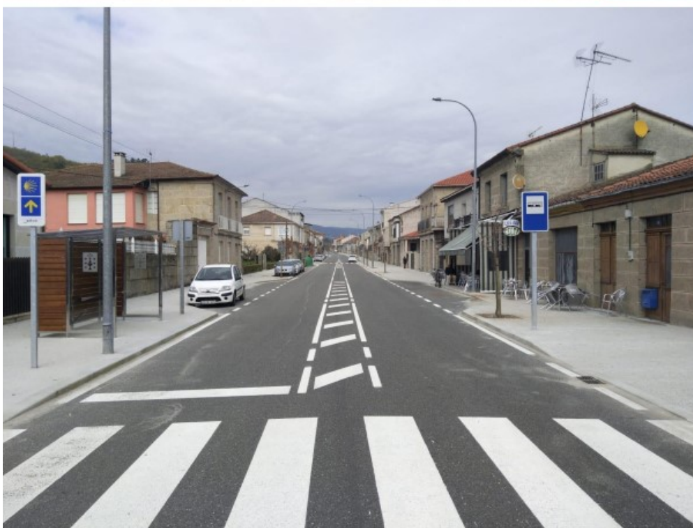
Antes e despois da obra, no PK 1+720 da OU-143
