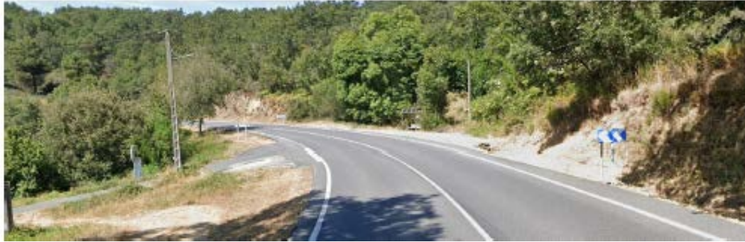
Intersección cara a Pradocabalos (P.Q. 10+500)
