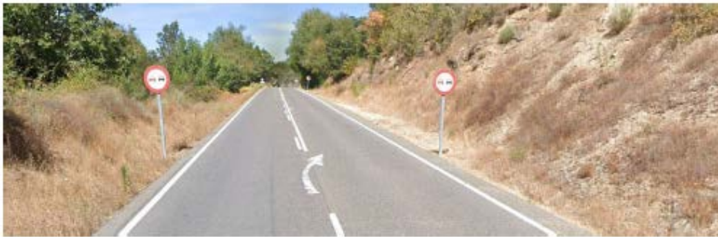
Recta ao final do tramo de proxecto (P.Q. 16+700)
